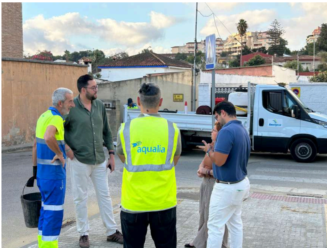
Los ediles y la presidenta de la Asociación en la zona de los trabajos
